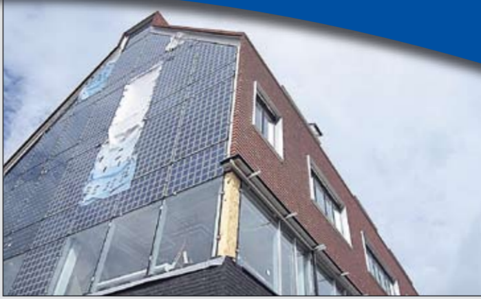
De zonnecollectoren (zwarte vierkanten) dragen bij aan de duurzaamheid van het nieuwe gemeentehuis.
