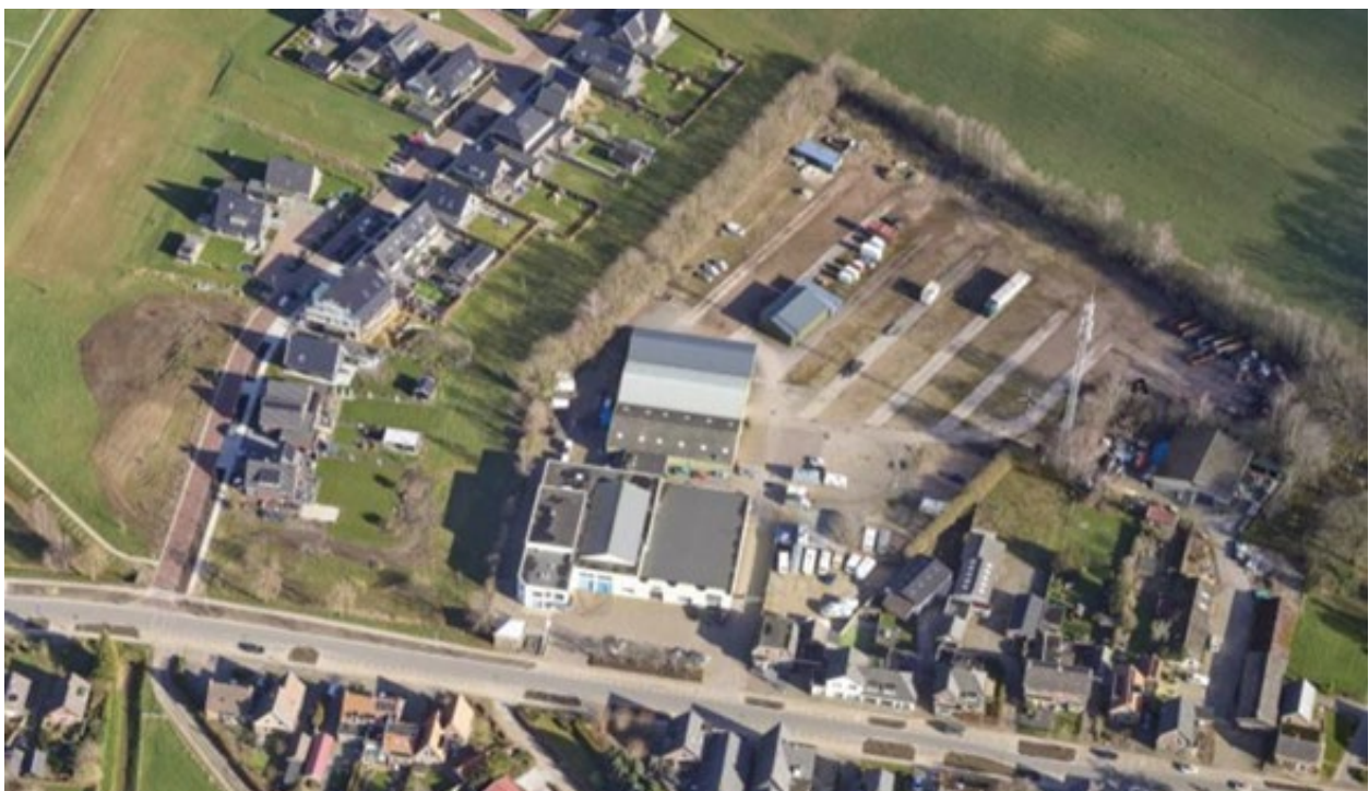
Figuur 2: locatie Raalterweg 48-50 in bestaande situatie gekeken in oostelijke richting (luchtfoto dd. 25 februari 2023)
